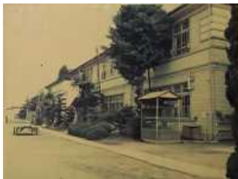
<大寄小学校の旧校舎の様子>
